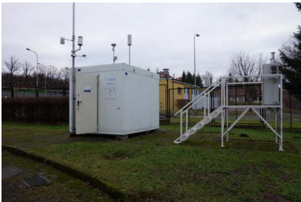
Rys.1.2 - Widok na stację pomiarową
